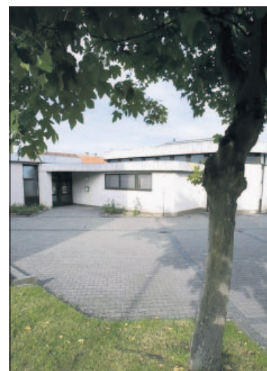
Die Kosten von rund einer Million Euro für den Umbau des Hauptstuhl-Pfarrzentrums in eine Mehrzweckhalle sorgten in der Ratssitzung für Zündstoff. —ARCHIVFOTO: VIEW
